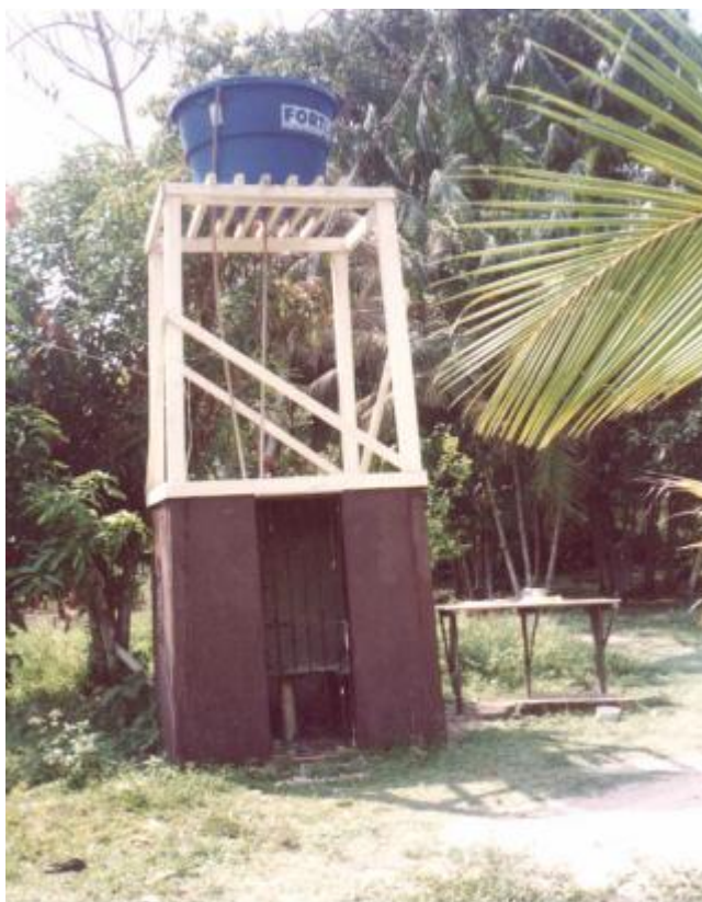
Figura 2: Poço tubular e ligação para caixa d'água na região de Belém. Fonte: Matta (2002)
